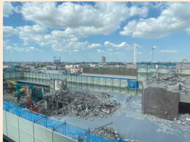
屋上の時計も取り壊され、解体工事進む。7階より10月3日現在。
