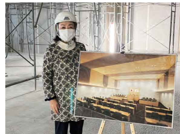
▲新本庁舎工事現場 議場にて (記事は4ページをご覧ください)
