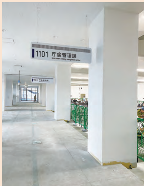
▲新本庁舎工事建設現場 1階の様子
