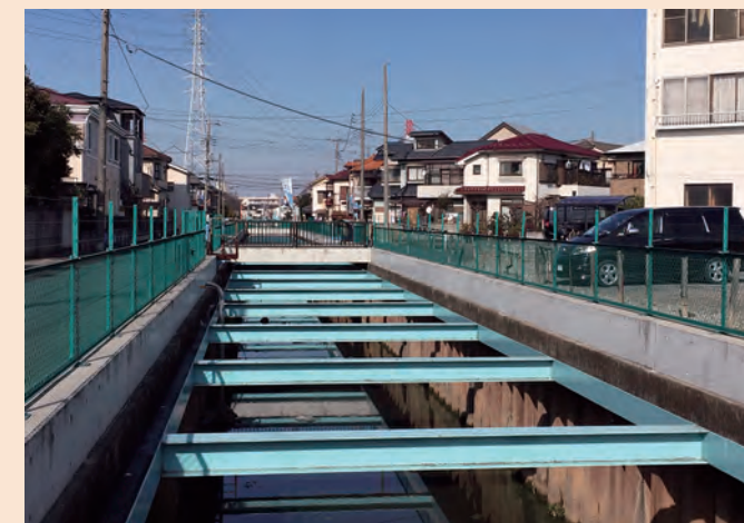
▲ 嵩上げされた出羽堀
